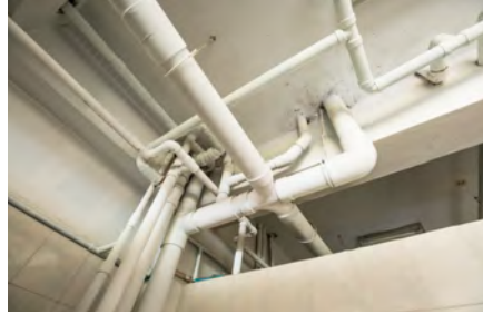
Resim 2.29. Binadaki su boruları
